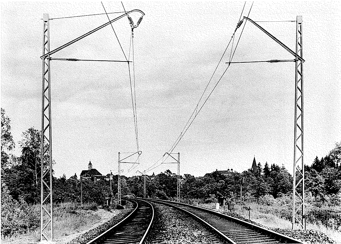
F 6.2./2 Elektrifizierung Augsburg - Ulm - Stuttgart 1933: Stützpunkte am Schrägausleger im Gleisbogen zwischen Leipheim und Günzburg [AEG]
