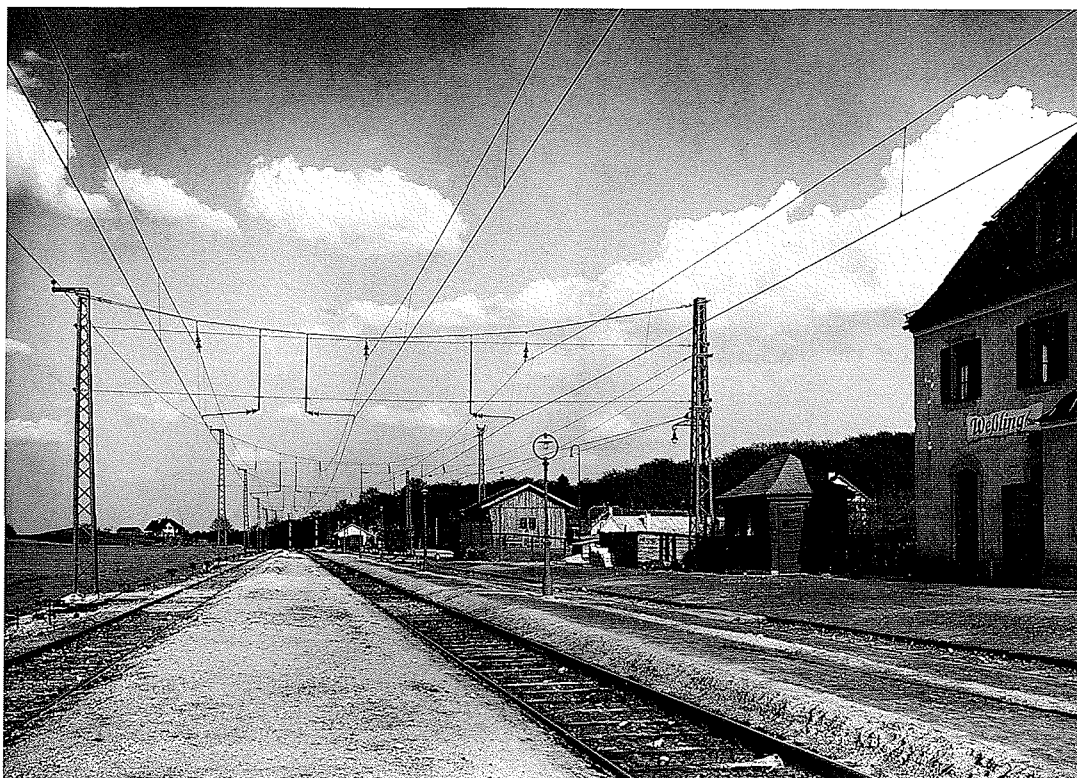
F 5.2.3./3 Elektrifizierung München-Pasing - Herrsching 1925: Querseilaufhängung in der Geraden (Bf Weßling) [SSW, Sammlung Jilek]
