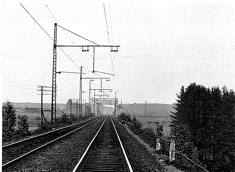
F 4.2./2 Elektrifizierung Lauban - Görlitz 1923: Mehrgleisaus- leger beim Einfahrtsignal Nikolausdorf Seite Lichte- nau [SSW 2.06. 1923, Samm- lung Jilek]
