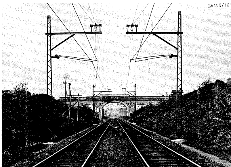
F 4.2./3 Elektrifizierung Lauban - Görlitz 1923: Zwischenmast der zweifeld- rigen Nach- spannung zwis- chen Lichte- nau und Niko- lausdorf [Siemens-Mu- seum München]
