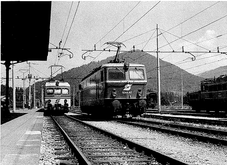
F 15.3./3 Elektrifizie- rung Thörl- Maglern - Tarvisio Cen- trale 1953: ÖBB 4030.317 und 1044.40 [Schwach 1984]
