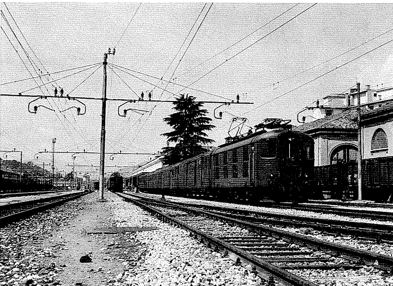
F 15.1./3 Elektrifizierung Pino - Luino 1960: SBB Re 4/4 I 10014 mit Zug 5568, im Hinter- grund Re 4/4 I 10007 für Zug 5572 in Luino [Schwach 1985]
