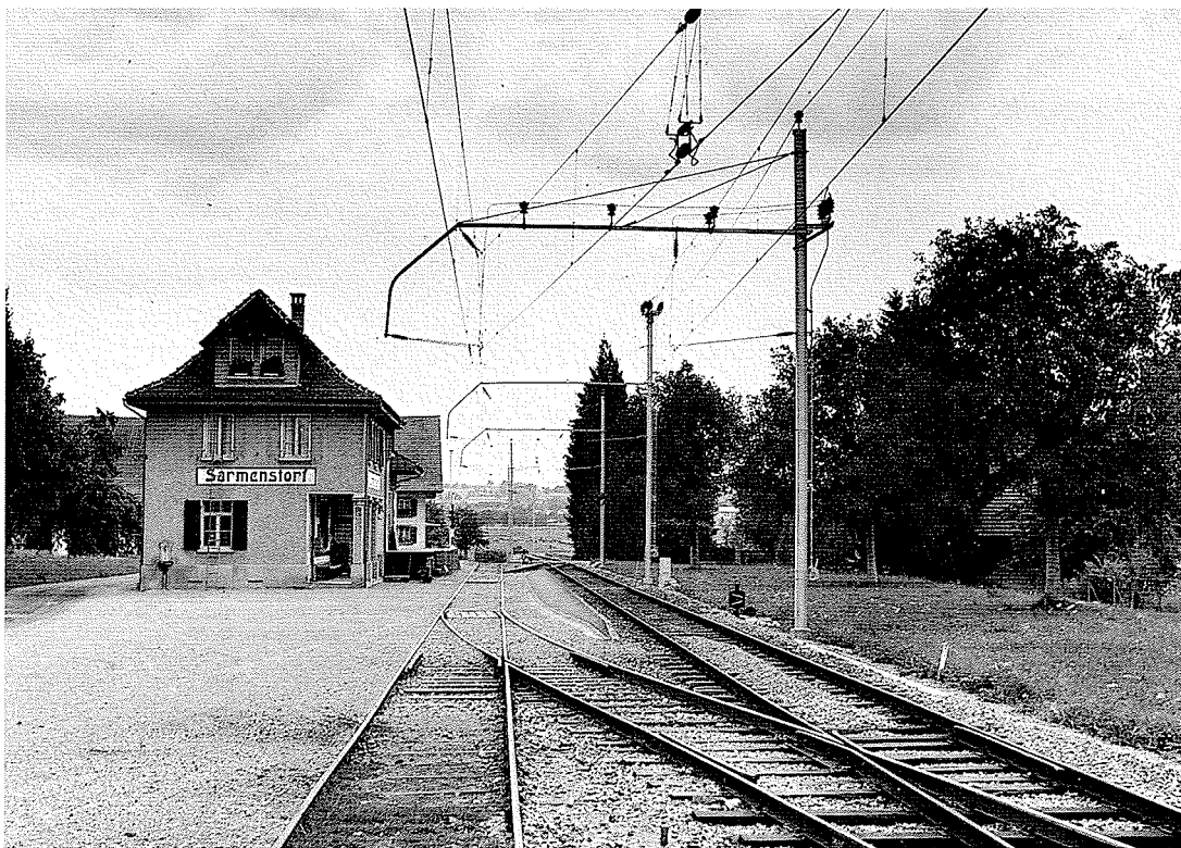
F 14.7.4.1./2 Umbau Wohlen - Fahrwangen-Meisterschwanden 1966: Mehrgleisenausleger in Sarmenstorf [Furrer+Frey]
