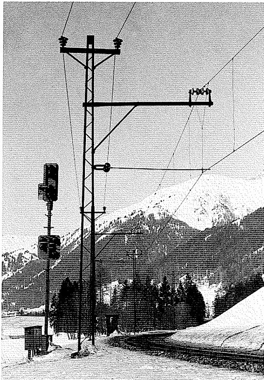
F 13.9.1./1 Umbaufahrleitung Schnann - St. Anton a. A.: Auslegerstützpunkt bogenau- ßen mit geteiltem Hänger [Schwach 1984]
