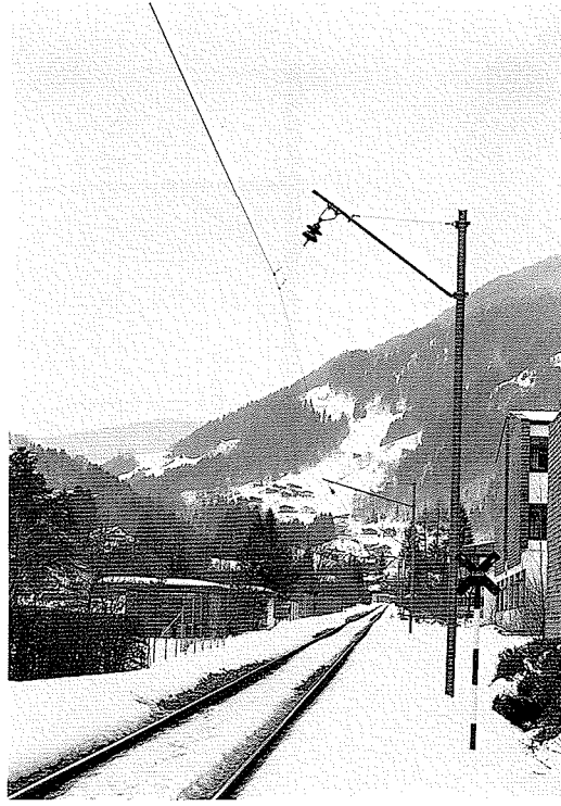
F 13.9.3./5 Systemumstellung Bludenz - Schruns 1972: Stützpunkt der Einfach-Fahr- leitung in der Geraden [Schwach 1984]
