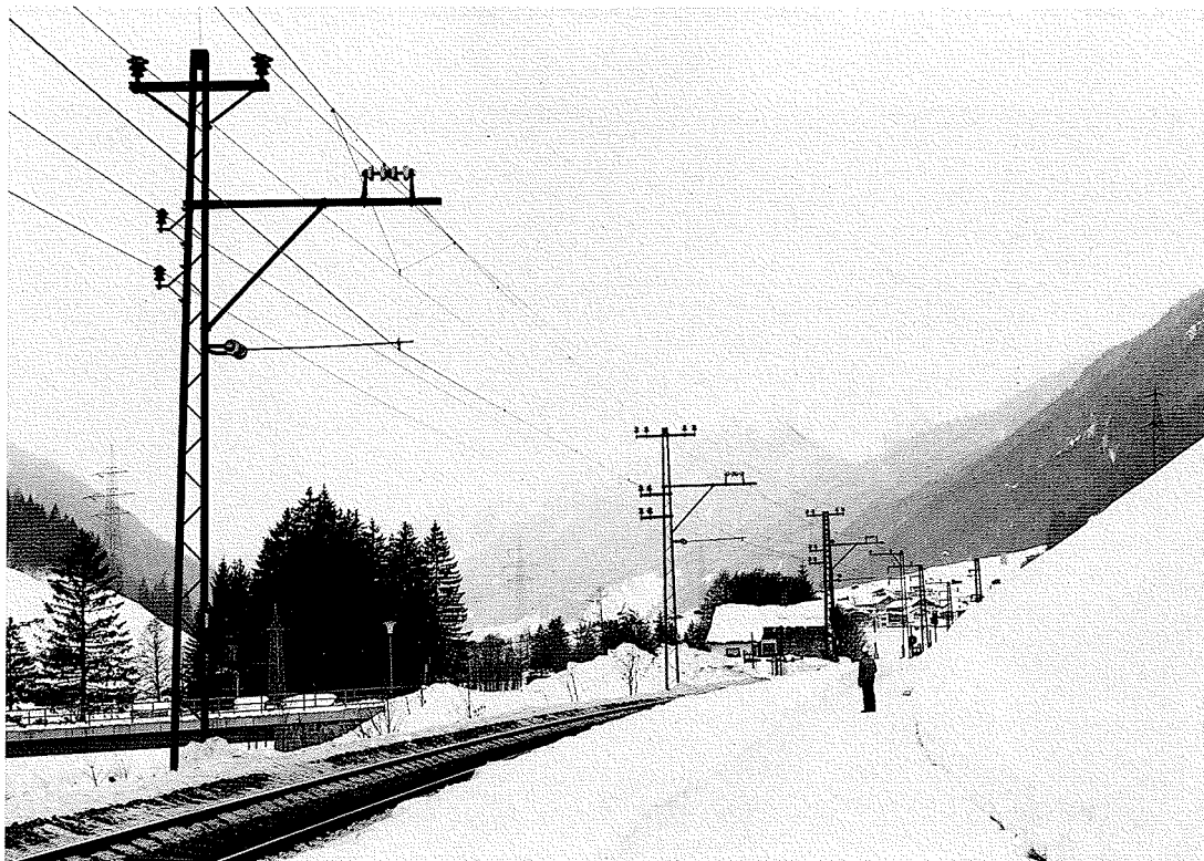
F 13.9.1./3 Umbaufahrleitung Schnann - St. Anton a. A.: Auslegerstützpunkte in der Geraden mit Y-Beiseil [Schwach 1984]
