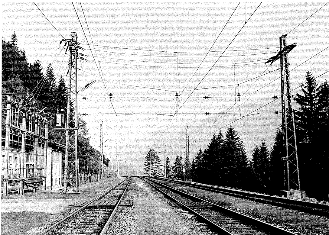
F 13.8.3.2./2 Doppelspurausbau Falkenstein - Penk 1971: Querseilaufhängung und Schaltgerüst im Bahnhof Penk [Schwach 1987]
