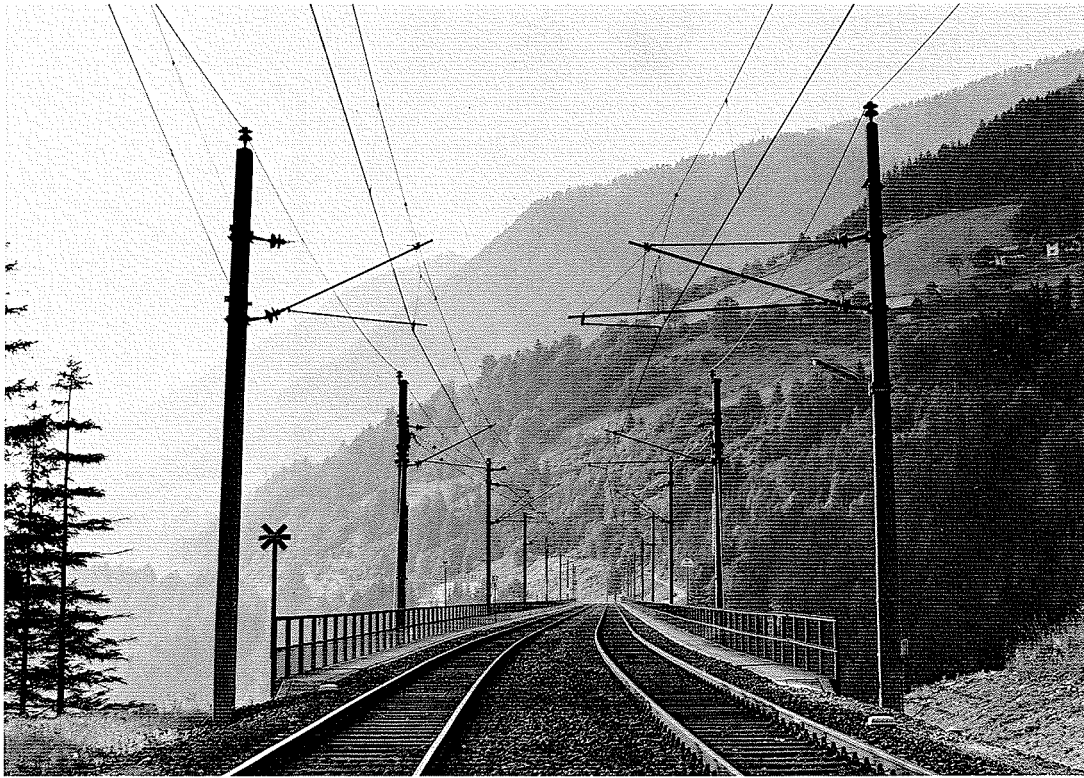
F 13.8.3.2./1 Doppelspurausbau Falkenstein - Penk 1971: Auslegerstützpunkte auf der Pfaffenberg-Zwenberg-Brücke [Schwach 1987]
