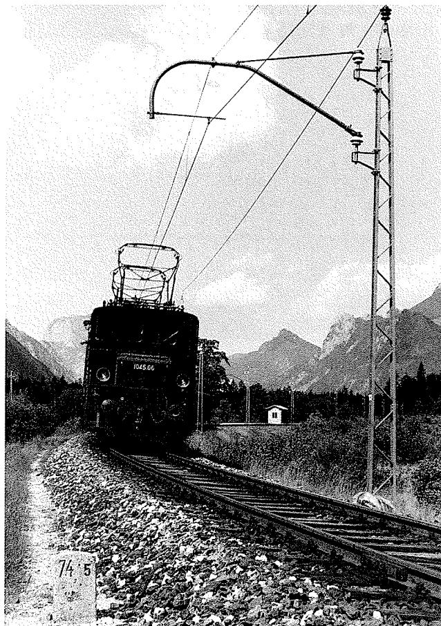
F 13.5.1.2./2 Elektrifizierung Bad Aussee - Ebensee 1924: Rohrschwenkausleger auf der Bogeninnensei- te bei der Haltestelle Lahnstein [Weigl]
