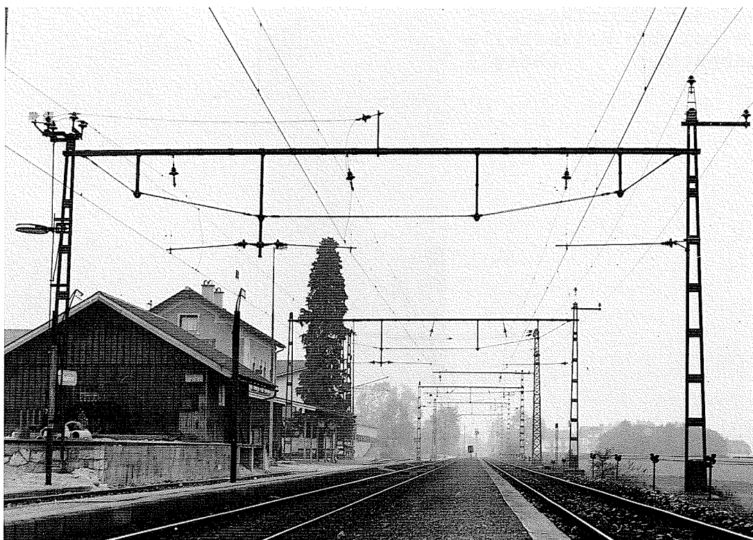
F 13.5.1.1./4 Elektrifizierung Ebensee - Att- nang-Puchheim 1924: Jochkon- struktion über 3 Gleise im Bahn- hof Traunkirchen [Schwach 1985]
